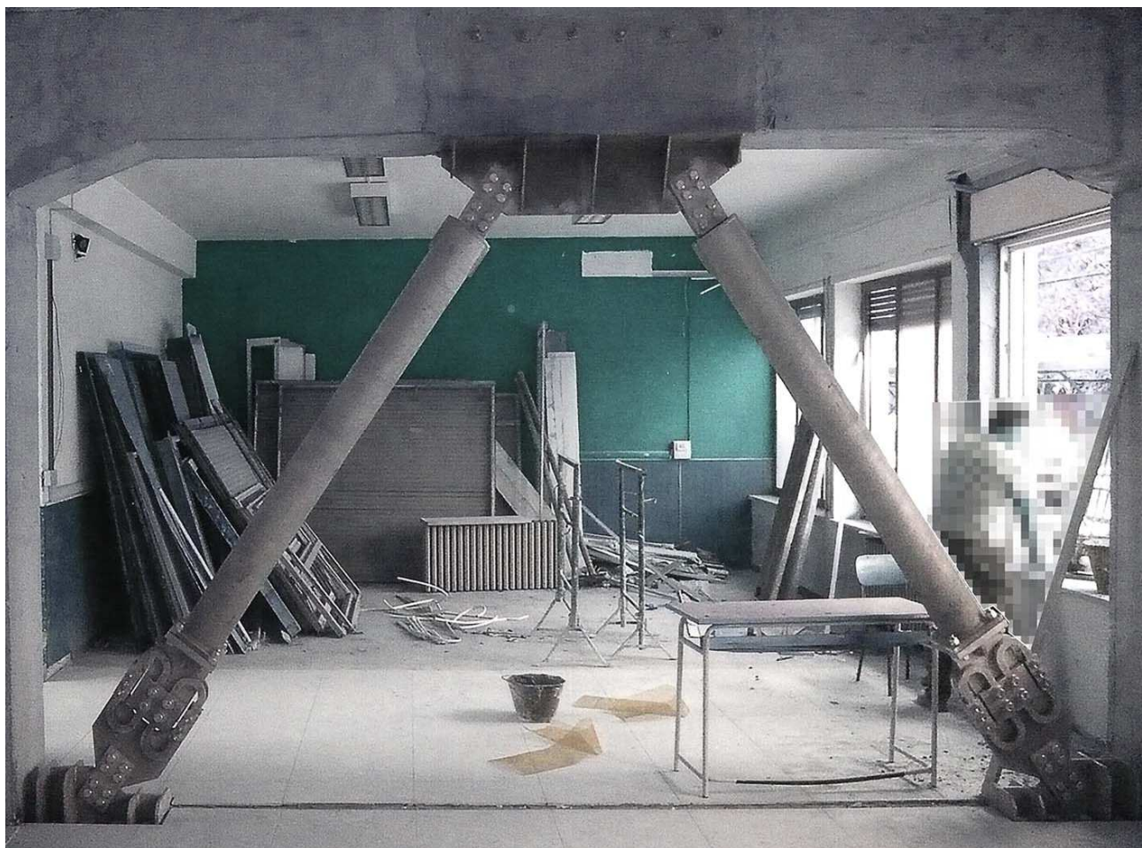
Installazione di controventi dissipativi
